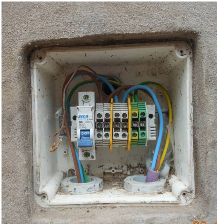
Detalle de Cajas de Conexión de columnas de iluminación con elemento de maniobra, Barra PE con tierra redundante y bornera para derivación fuera de cámara.
